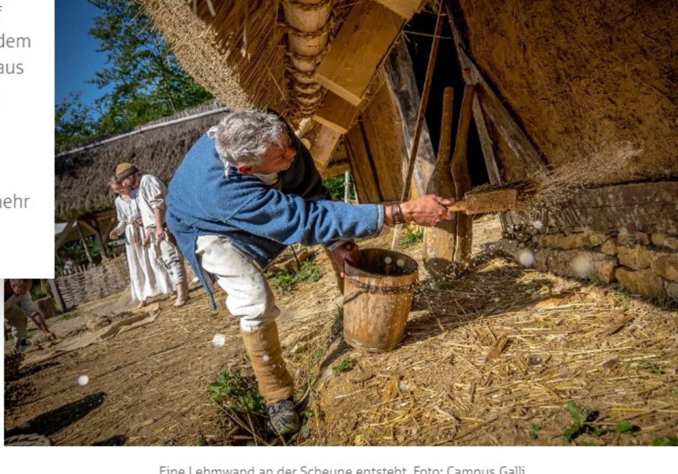
Eine Lehmwand an der Scheune entsteht. Foto: Campus Galli
