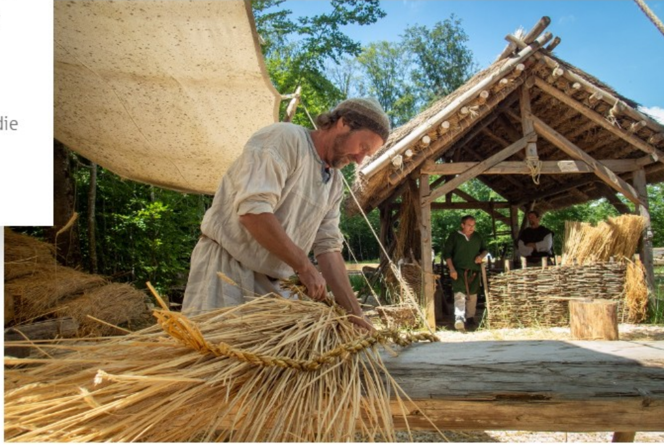
Vorbereitung für das Strohdach. Foto: Campus Galli
