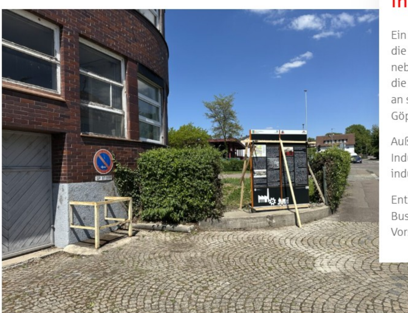
Bauphase der Boehringer-Stele
